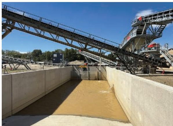
Bassin de décantation après le poste primaire, recevant les eaux de process et les eaux pluviales.
